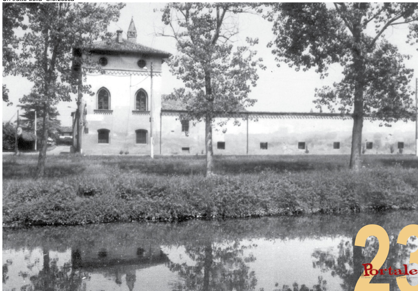
Un tratto della “Sforzesca”
